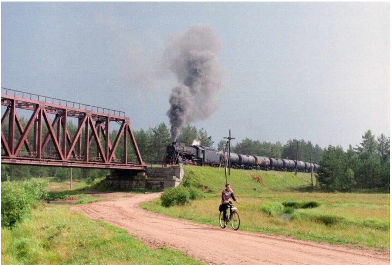
Рисунок 1.2 – Нефтеналивной поезд под паровозом серии Л следует по мосту через реку Шлинка на 27 км Бологое-Полоцкой железной дороги (участок Бологое-Великие Луки ОКТ жд). Фото: Аркадий Ликальтер, ВОЛЖД [43]
